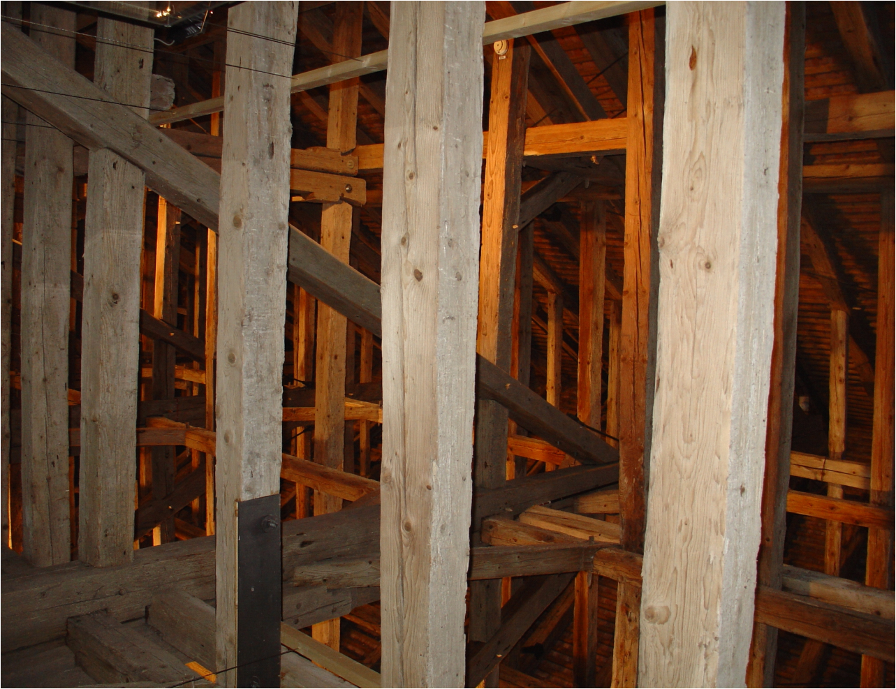
Blick in den Dachstuhl der "Spitalkirche"
